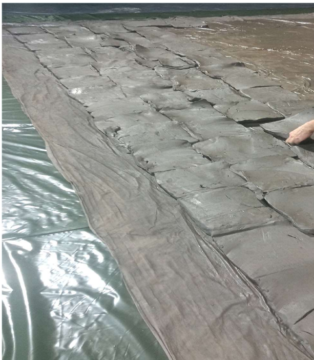
PHOTO 3 : Montage des tranches d'argile
